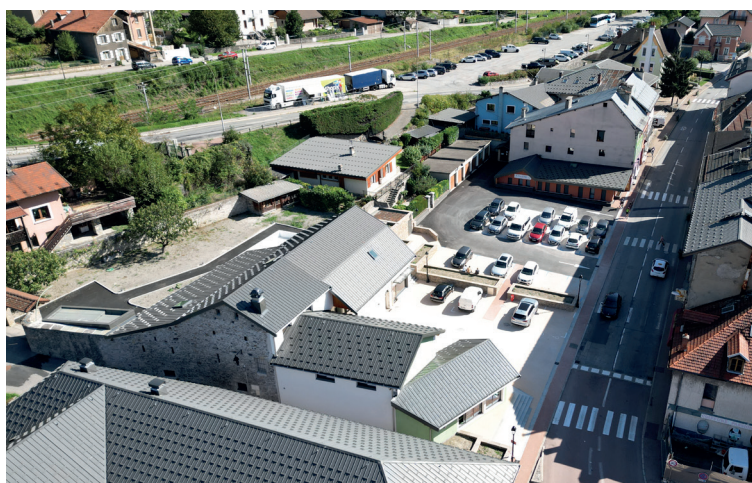
Grand-Aigueblanche, le centre-bourg après travaux
