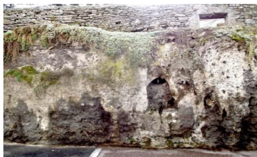
Mur en tuf
