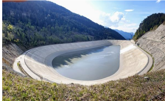
Retenue de La Coche
